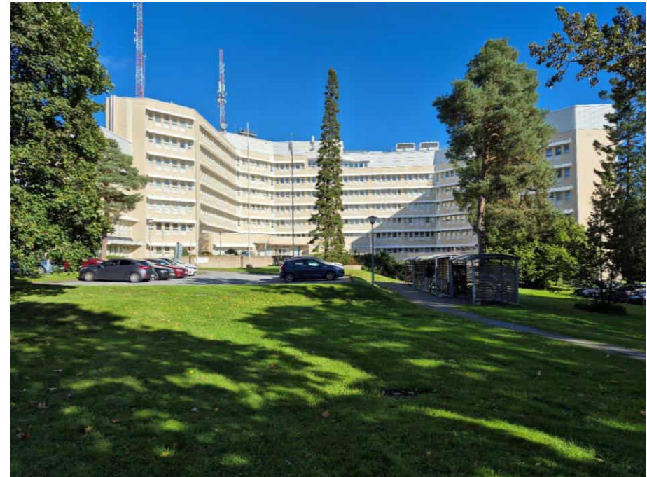
Kuva 21. Vaasan 1982 valmistunut uusi virastotalo. Kuvausajaksi syksyllä 2025 Sitowise Oy.
