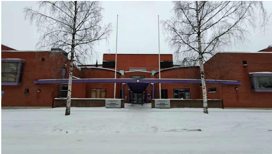
Kuva 36. Pohjoisjulkisivu ja pääsisäänkäynti.
