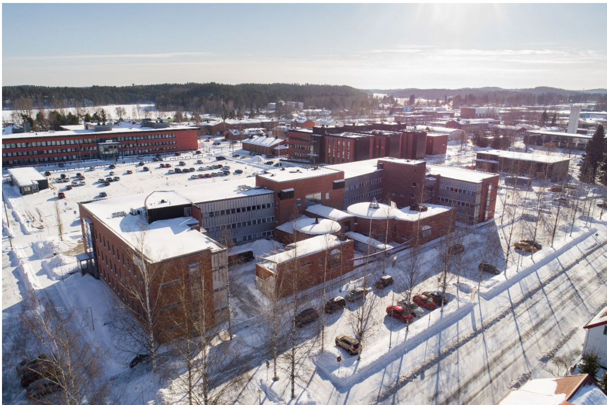
Kuva 2.1. Suunnittelualueella sijaitseva toimistorakennus (etualalla) sekä päivittäistavarakauppa (taka-alalla oikealla). Kuva: Millstream Oy
