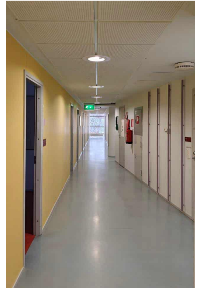
Kuva 64. Länsisiiven käytävä 3. kerroksessa (A320). Käytävätilojen lattiapintana on todennäköisesti alkuperäinen vaaleansininen linoleumimatto. Paikoin seinillä on koristeprofileja, vaaleanvioletilla maalattuja (oikealla).
